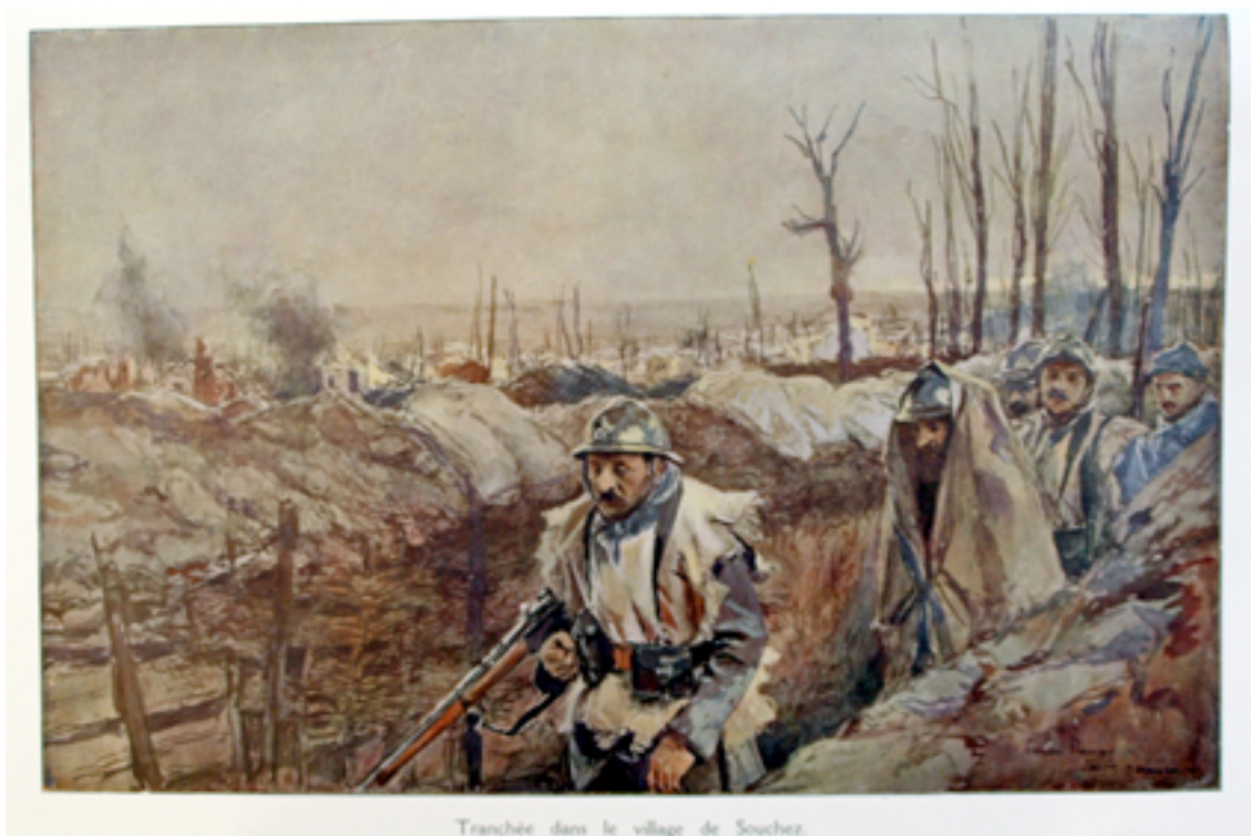
Tranchée dans le village de Souchez
